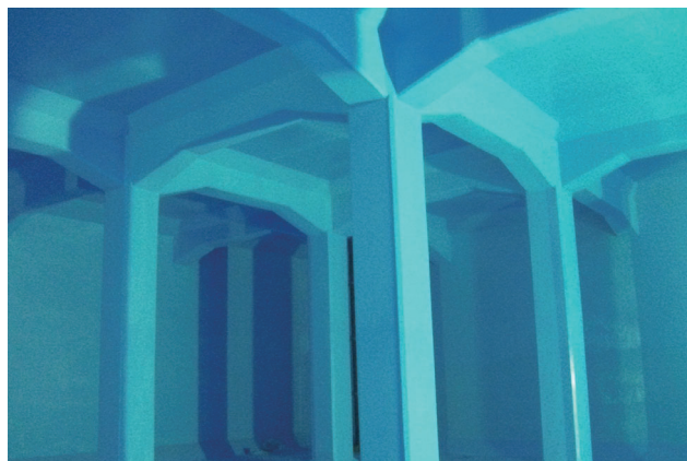
上水施設(配水池)
