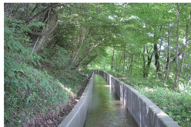
農業施設(開水路)
